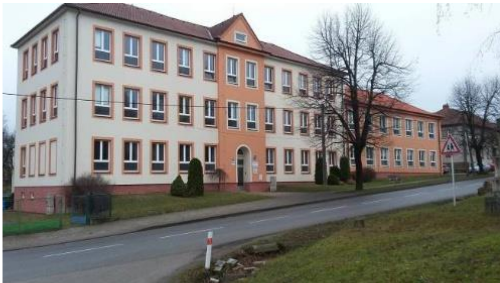
Hlavní budova ZŠ Předín
